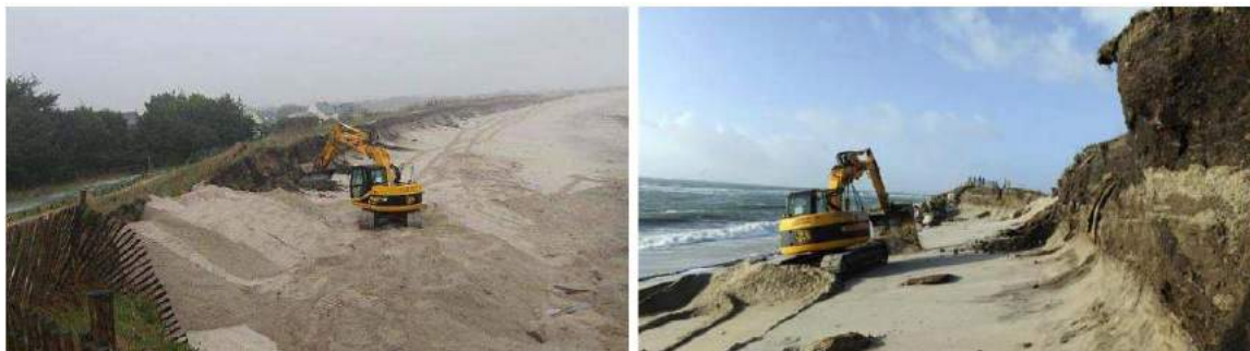
Travaux d'urgence entrepris sur le cordon dunaire à l'est de la Pointe du Léhan (commune de Treffiagat) (photo Ouest France 5 et 6 janvier 2014)
